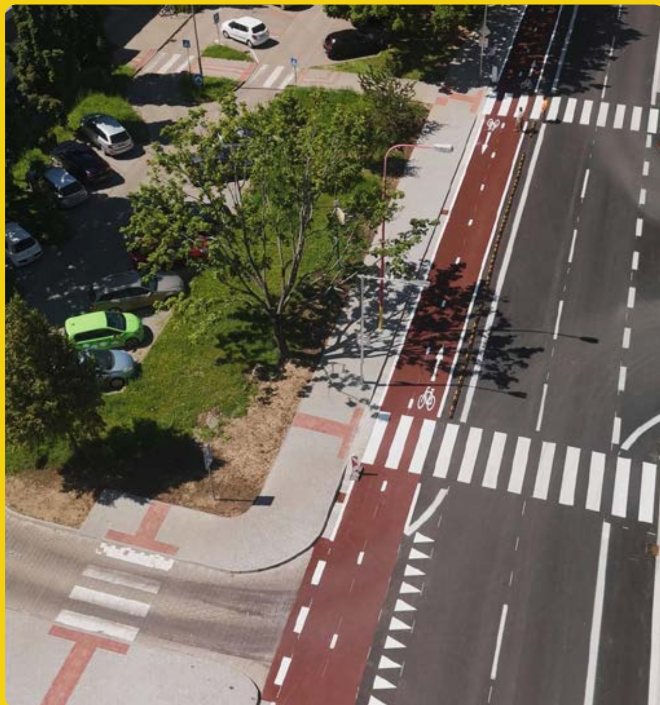
Komplexná obnova kľúčových cestných ťahov
